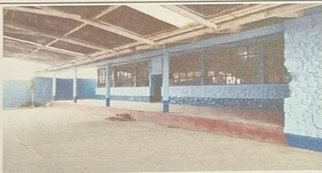
Foto 3: Terminación lado frontal.
