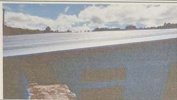
Foto 1: Tejado de la Escuela parte superior lado oeste.
