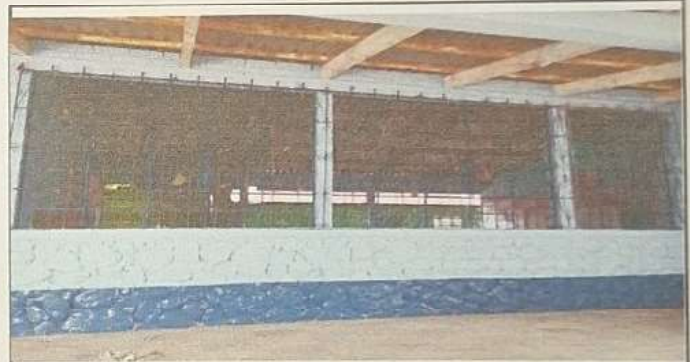
Foto 4: Terminación de ventana de metal más vidrio.
