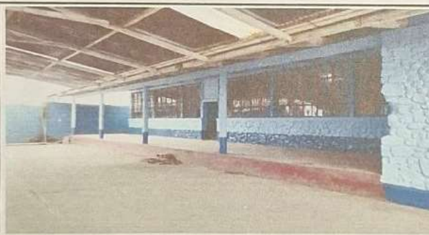
Foto 3: Tejado de la escuela parte frontal.
