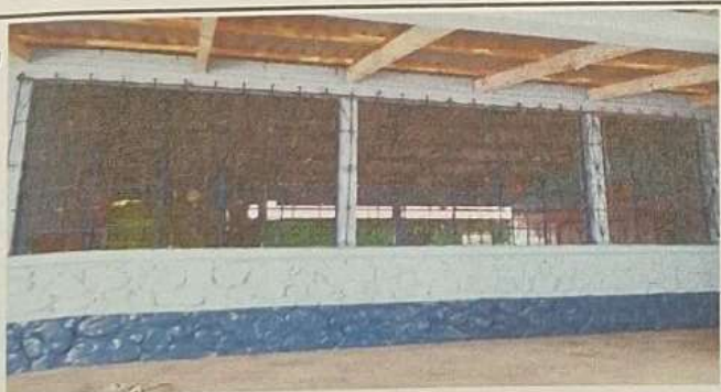
Foto 5: Terminación de pintura lado exterior.
