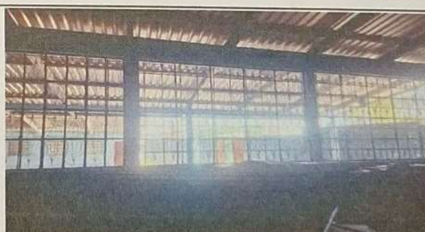
Foto 6: Sustitución de ventana de madera por metal más vidrio parte interior del aula de Primero A.
