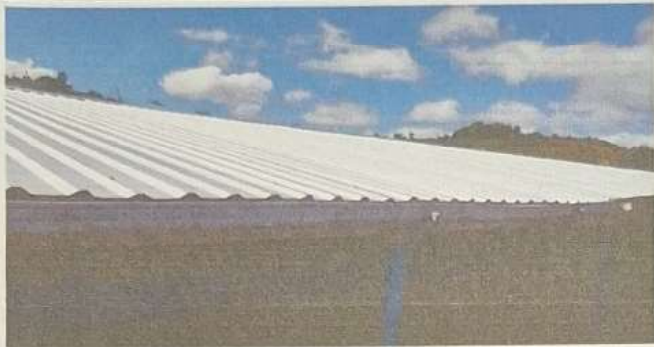
Foto 1: Terminación de techado parte superior lado oeste.
