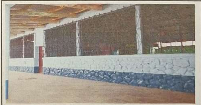
Foto 6: Terminación de ventana de metal.
