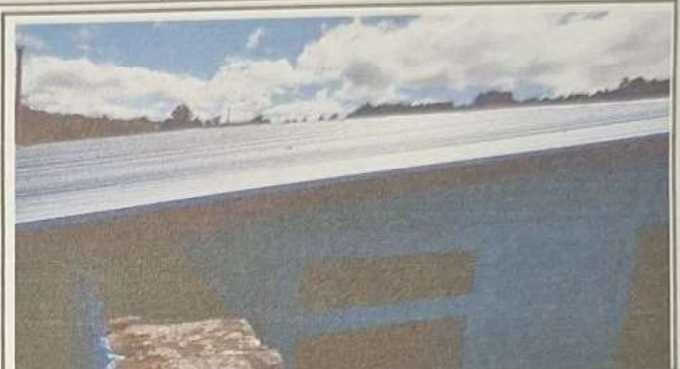
Foto 2: Terminación de techo parte superior lado oeste.
