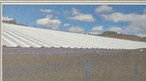
Foto 2: Tejado de la escuela parte superior lado este.
